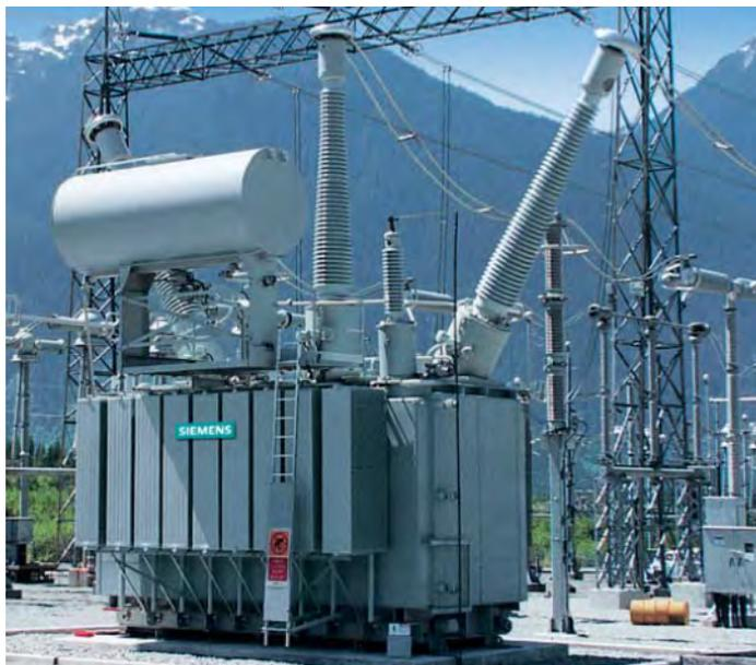
Figura 30. Inductor en derivación (unidad trifásica) utilizado para la compensación de tensión de una línea de transmisión ca de alta tensión. Cada brazo largo en la parte superior de la unidad de la imagen es un aislante que brinda acceso a un extremo de un inductor (©Siemens AG 2014, todos los derechos reservados).
