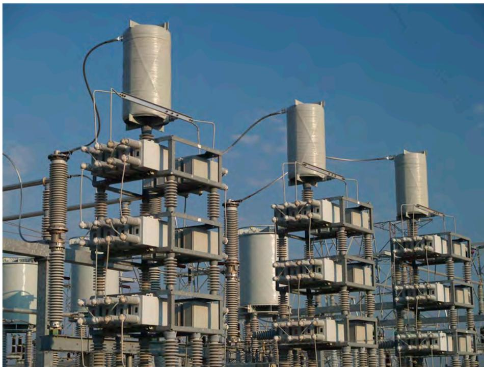
Figura 31. Banco de condensadores en derivación utilizados para compensar la tensión en el extremo receptor de una línea de transmisión ca de alta tensión.
