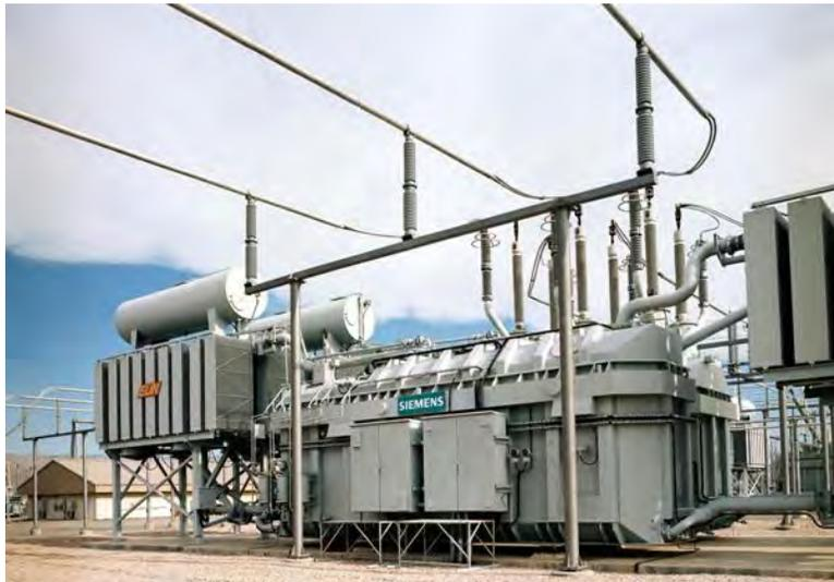
Figura 55. Transformador de cambio de fase utilizado para controlar el flujo de potencia activa a través de una línea de transmisión ca en una red eléctrica interconectada (©Siemens AG 2014, todos los derechos reservados).
