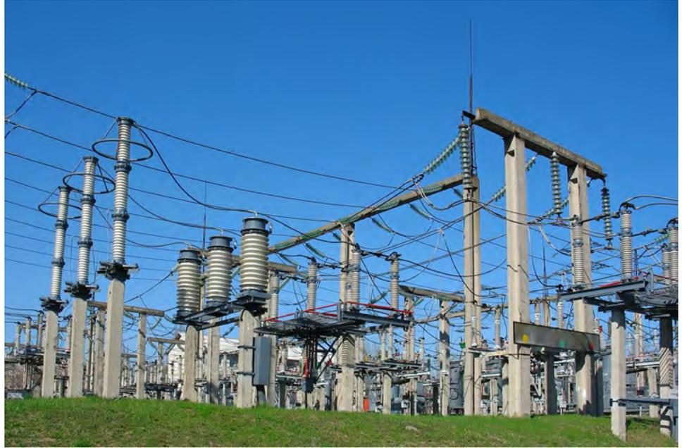
**Figura 2. Subestación de transmisión utilizada para bajar la alta tensión presente en las líneas de transmisión ca antes de que la energía se les distribuya a los consumidores.**
